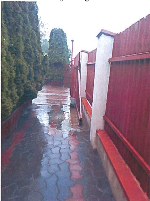
Brama przesuwna i wjazd na nieruchomość, widok z narożnika południowo-zachodniego
