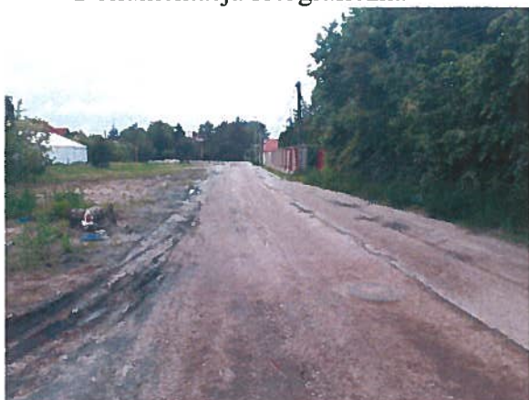
Dojazd od ul.Śląskiej (kierunek wschód)
